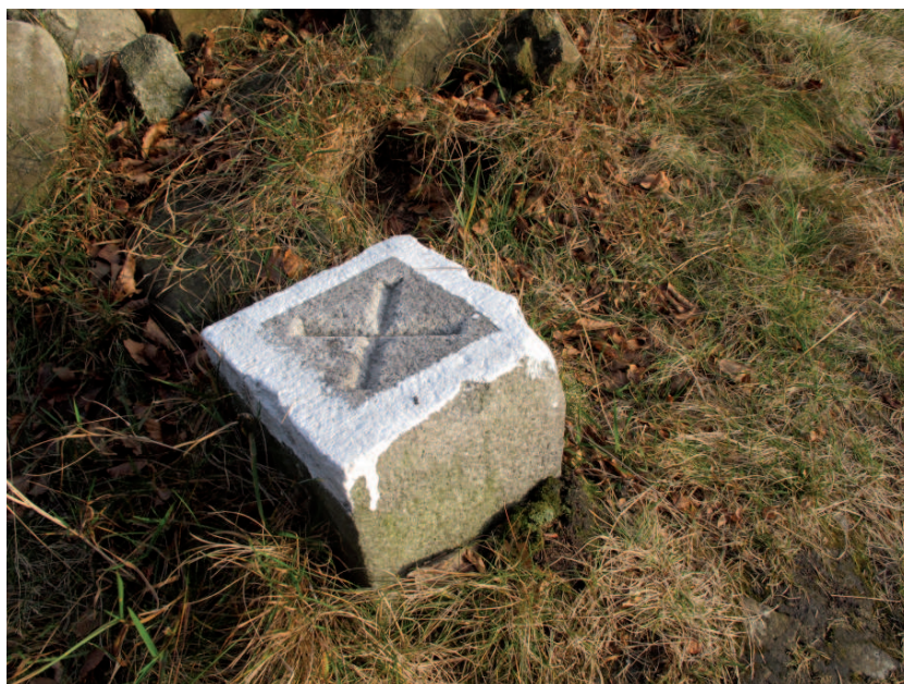
Obr. 3.3: Stabilizace geodetického bodu
